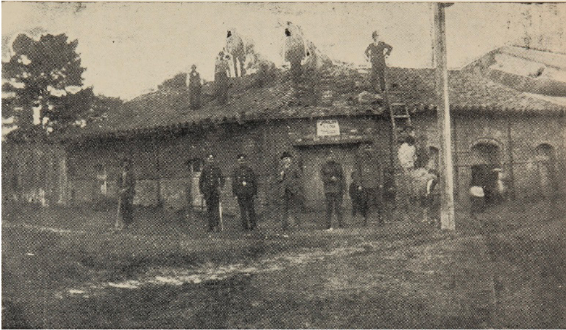
Figura 2 Proceso de demolición conventillo Don Coste Aruta, Concepción en Revista de la Habitación, Nº 17, mayo de 1921, p. 393.
